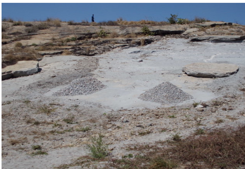
Foto 6 – Exploração ilegal de granito (para a construção civil) o que instabiliza a vertente de uma montanha localizada próximo de uma área residencial nos arredores de Nampula
